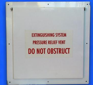
7.4.1 La sala protegida deberá tener suficiente resistencia estructural e integridad para contener la descarga del agente extintor. Se dispondrá de venteos para evitar una presurización excesiva, ya sea negativa o positiva, de la sala. La norma ISO 21805 ofrece una guía sobre el cálculo de ventos para sistemas gaseosos.
